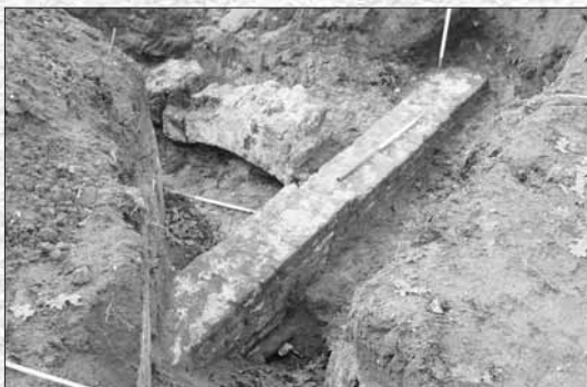
De fundamenteën van het gebouw in de kasteeltuin
