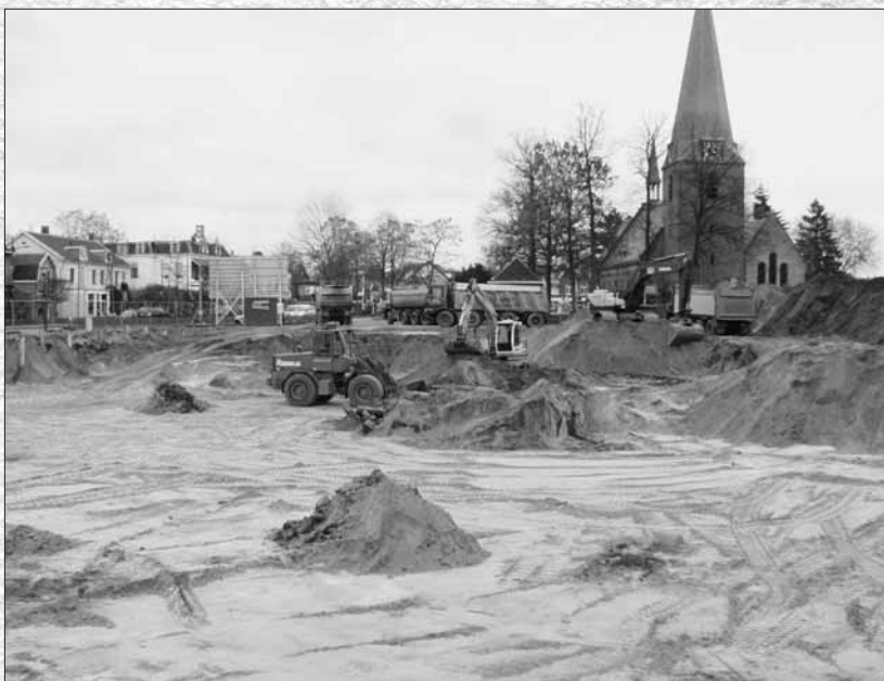
De bouwput op het Raadhuisplein in Doorn
